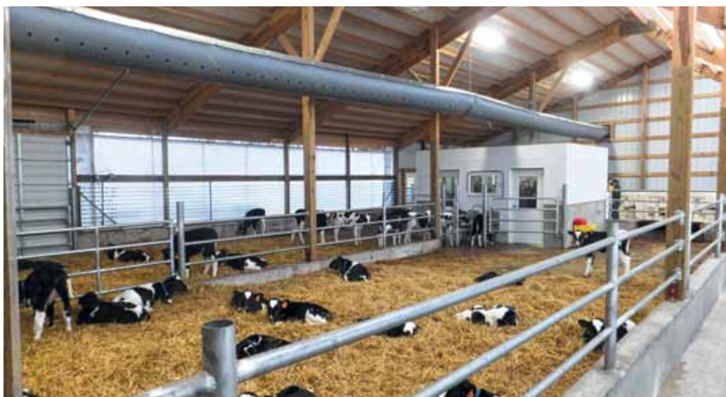
Abb. 1: Das Positiv-Luftdruck-Ventilationssystem: Schläuche (Tubes) über dem Liegebereich sorgen dafür, dass Frischluft in den Raum gelangt, ohne Zug zu verursachen.
